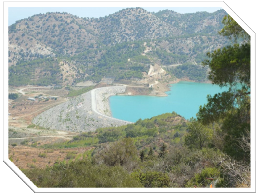
Blick auf den Staudamm von Geçitköy in Nordzypern [7].
